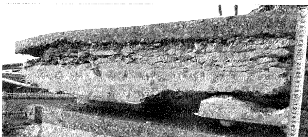
写真1 損傷床版
